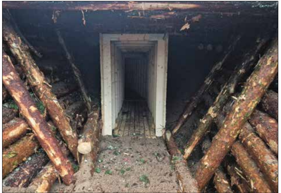
Taisteluhaudan suuaukko. Kaikkien joukkojen tulee osata toiminta linnoitetuissa asemissa, vaikka niitä ei itse pääsisi rakentamaan.
