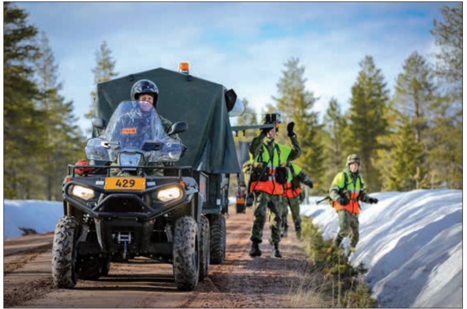
Kaapelijoukkue rakentamassa kenttäkaukovalokaapeliyhteyttä Army North –harjoituksessa Rovajärvellä toukokuussa 2017.
